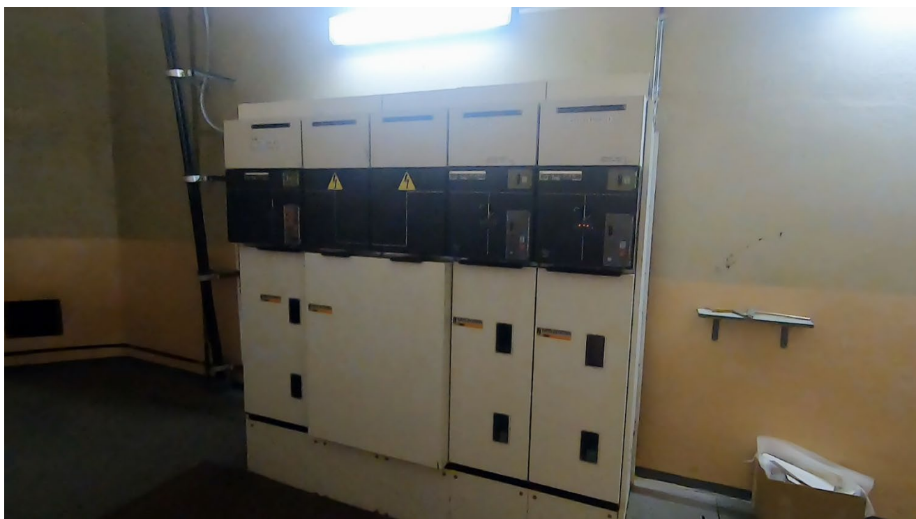
Obrázek 2 – Stávající rozvodna VN (Vysokonapěťová podélná spojka)
